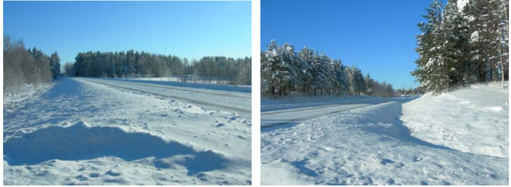
Kuvat 6 ja 7. Näkymät nykyisestä tonttiliittymästä itään ja länteen.
